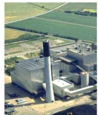
Fig. 2. 300 MW SNOX™ equipped power plant of Nordjyllandsværket, Denmark
