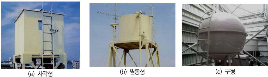
〈그림 2〉 복합재료 일체형 물 저장탱크
